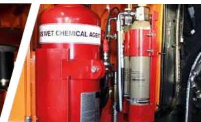
Sistema automático de extinção de incêndio.
